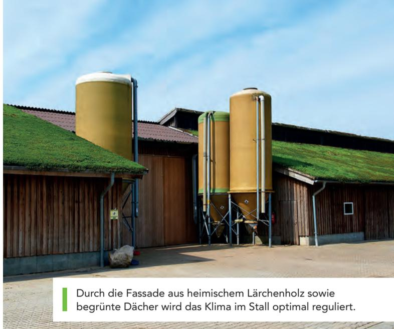
Durch die Fassade aus heimischem Lärchenholz sowie begrünte Dächer wird das Klima im Stall optimal reguliert.
